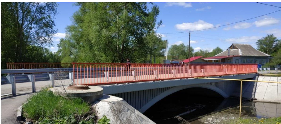
Рис.1 – Двухполосный автомобильный мост в Ульяновской области длиной 20 м, шириной 12 м с максимальной нагрузкой – до 100 тонн
